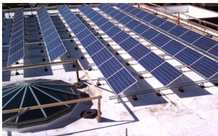
Fig. 1.13 – Sistema de fixação em telhado plano. A distância entre as fileiras é definida a partir do trade-off entre perdas por sombreamento e área aproveitada.
