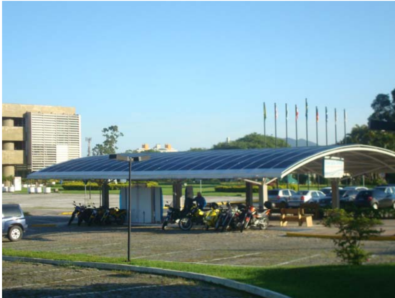
Estacionamento ELETROSUL, 12 kWp (2009)
