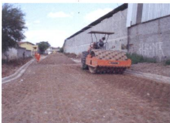
Compactação de subleito de RCC
