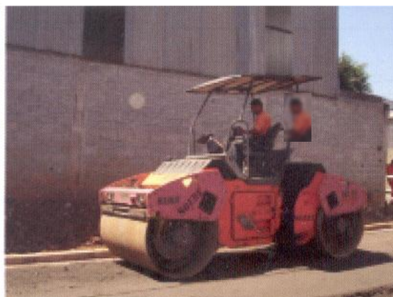
Compactação da base de RAP espumado
