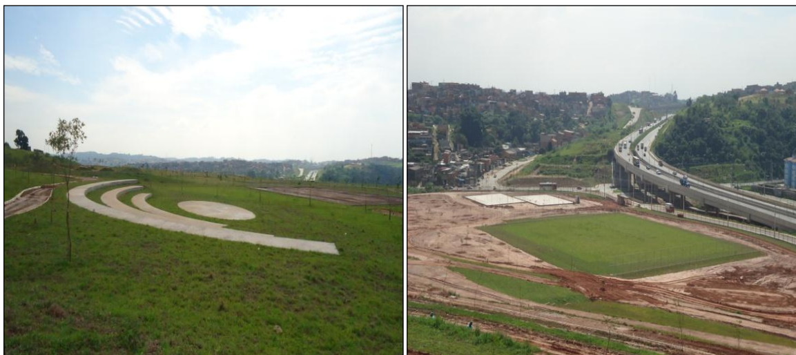
Fotos: obras de execução de equipamentos públicos no Parque Municipal em implantação no aterro desativado Sapopemba
