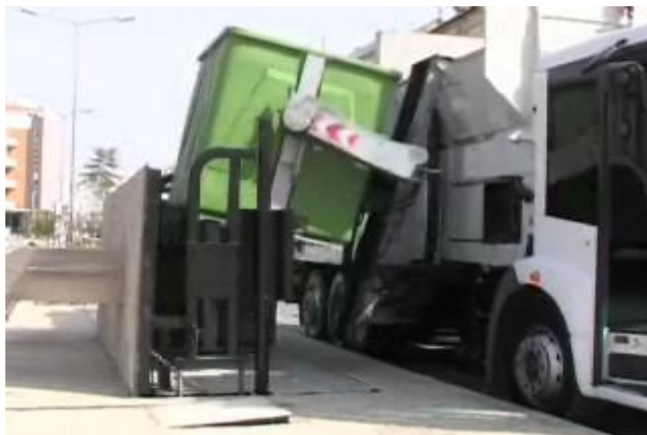
Foto: operação de remoção do contêiner subterrâneo sidetainer
