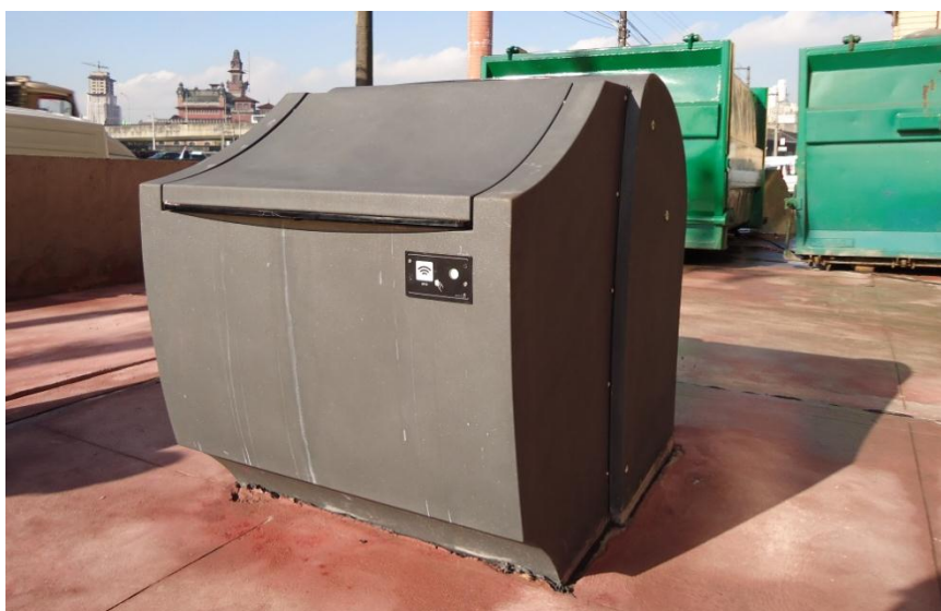
Foto: câmara de recepção do bigtainer instalado junto ao Mercado Municipal Central
