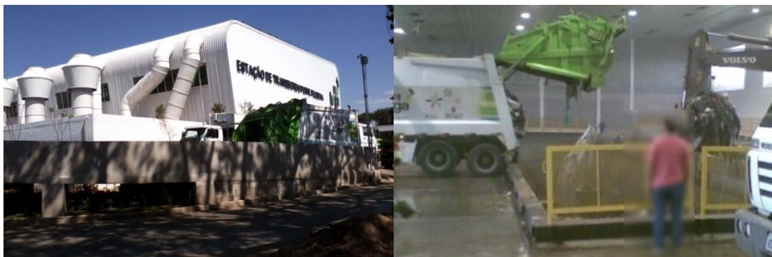
Fotos: Estação de Transbordo Ponte Pequena
