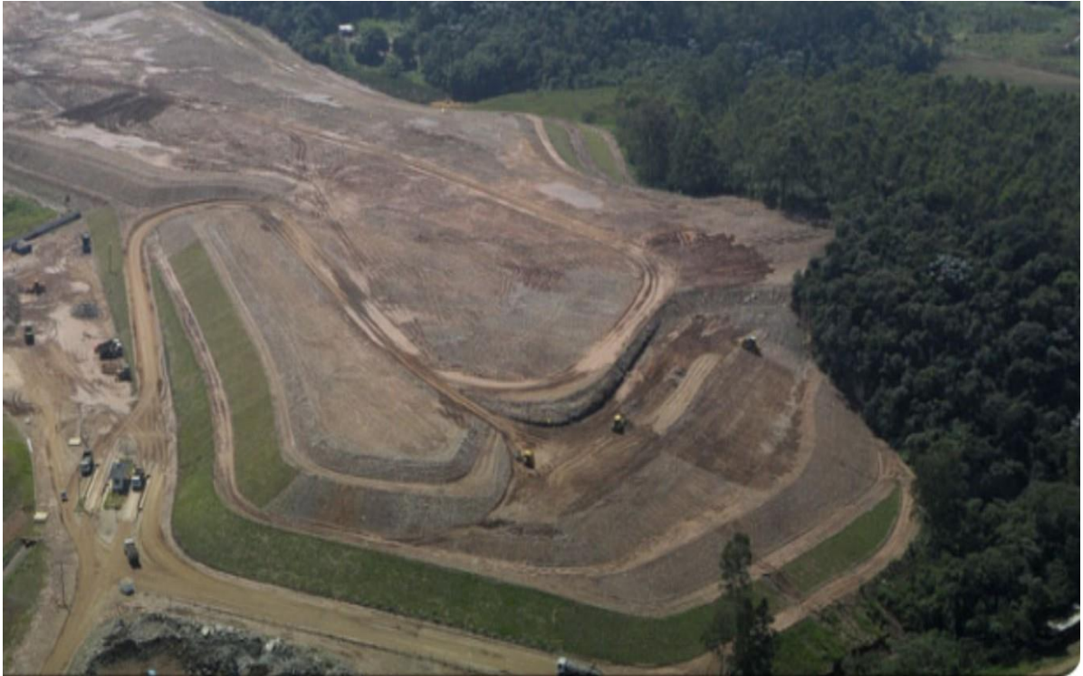
Foto: vista aérea do Aterro de RCC Privado - CTR Grajaú, no distrito de Grajaú
