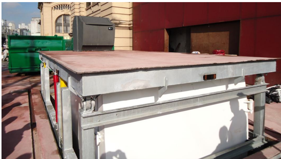
Foto: elevação do bigtainer de coleta mecanizada no Mercado Municipal Central
