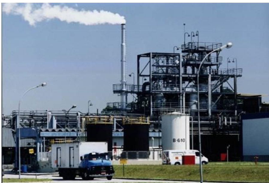
Foto: incinerador Grupo B perigoso
