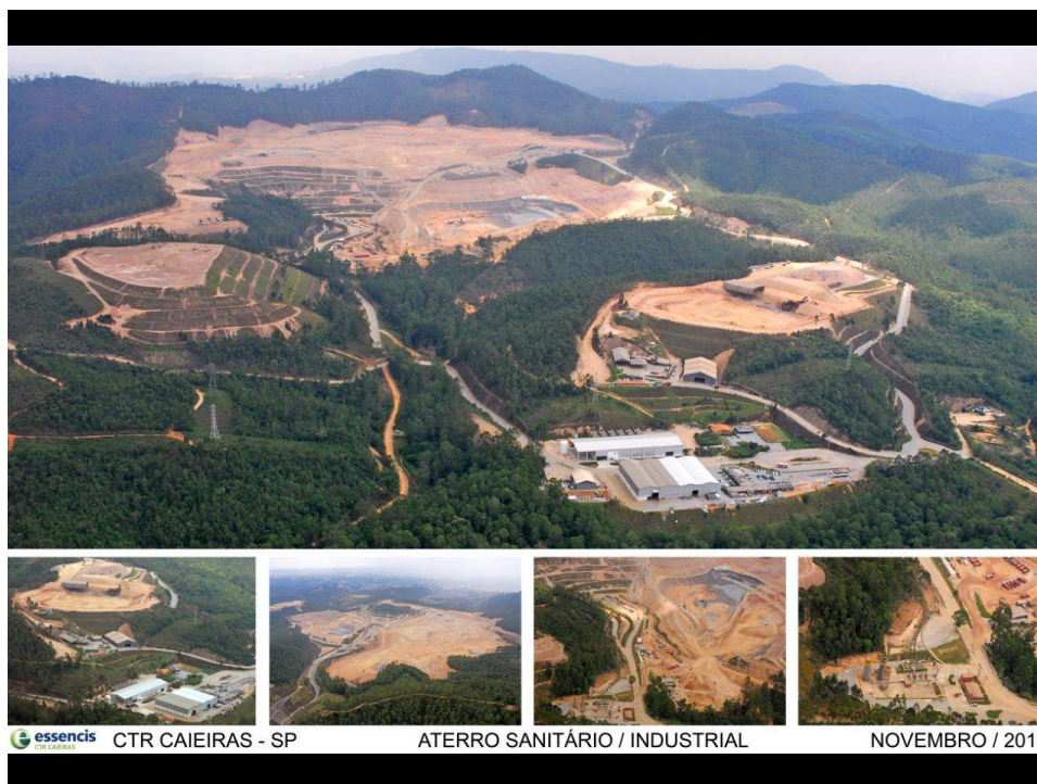
Painel: Central de Tratamento Caieiras
