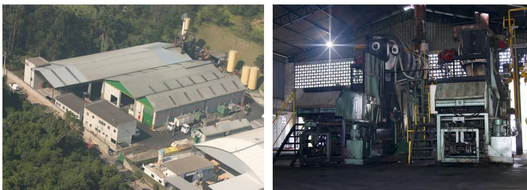
Fotos: incinerador Grupo B
