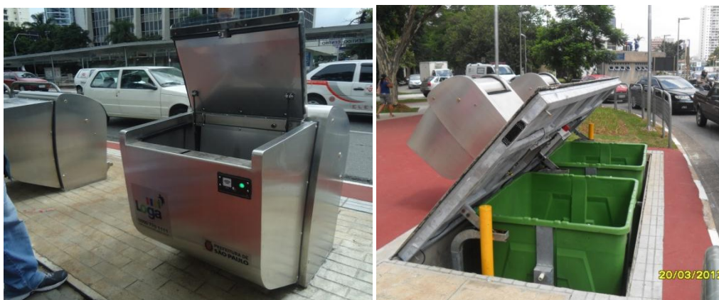
Fotos: contêineres subterrâneos para coleta mecanizada de RSD na Av. Faria Lima
