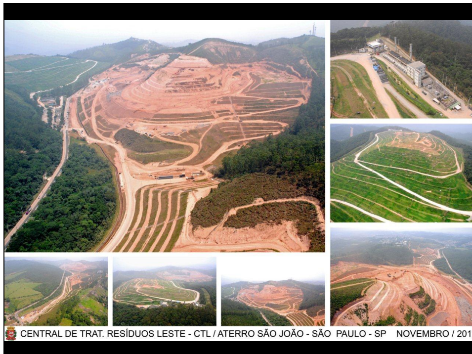
Painel: Central de Tratamento Leste - Aterro Sanitário São João
