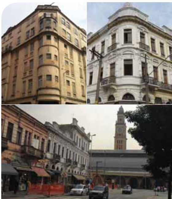
CONJUNTO DA LUZ Á ACIMA E, NO ALTO, PRÉDIOS DE ESQUINA
