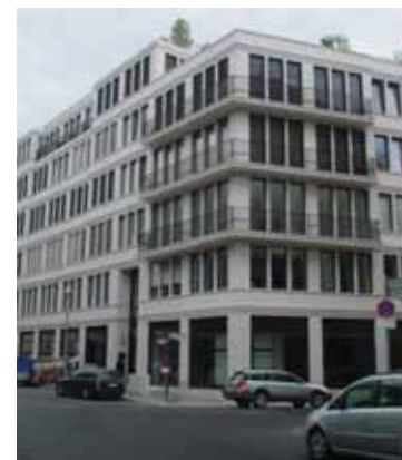
EXEMPLOS DE TRATAMENTO DA ESQUINA E ACESSO À EDIFICAÇÃO
