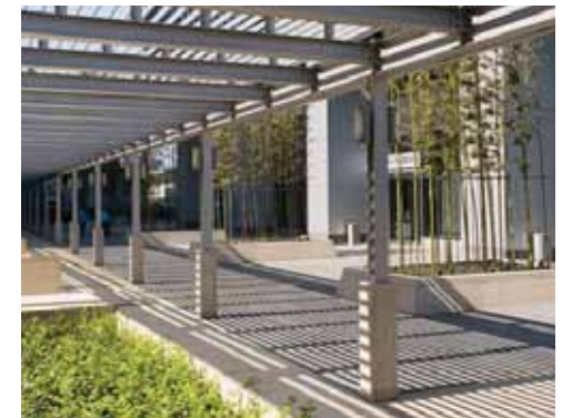
EXEMPLO DE ÁREA SOMBREADA COM PERGOLADO
