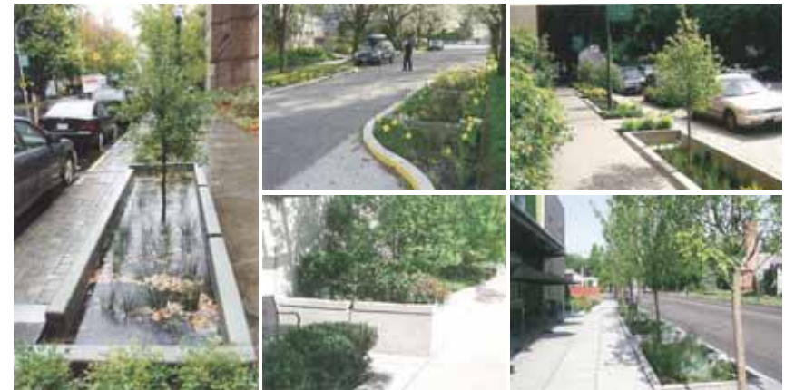
FIGURA 4 – EXEMPLOS DE DISPOSITIVOS DE INFRAESTRUTURA VERDE – E JARDINS DE CHUVA.
