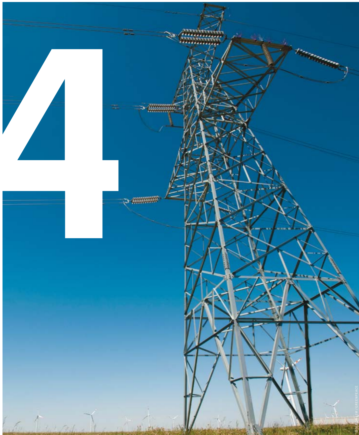
imagem LINHAS DE TRANSMISSÃO NO PARQUE EÓLICO GUOHUA, NA CHINA.
